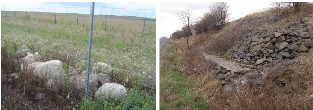
Figura 44. Utilizarea de bolovănișuri ca microhabitate este în măsură a oferi nișe suplimentare ecologice (stânga) și funcționând ca zone de drenaj a apelor de spălare ce contribuie substanțial la stabilizarea pantelor (dreapta).
