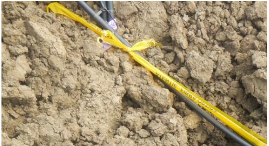
Figura 10. Model de pozare a unui cablu electric însoțit de panglica de avertizare
