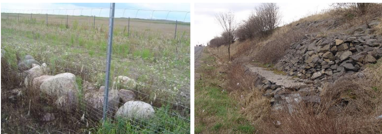
Figura 31. Utilizarea de bolovănișuri ca microhabitate este în măsură a oferi nișe suplimentare ecologice (stânga) și funcționând ca zone de drenaj a apelor de spălare ce contribuie substanțial la stabilizarea pantelor (dreapta)
