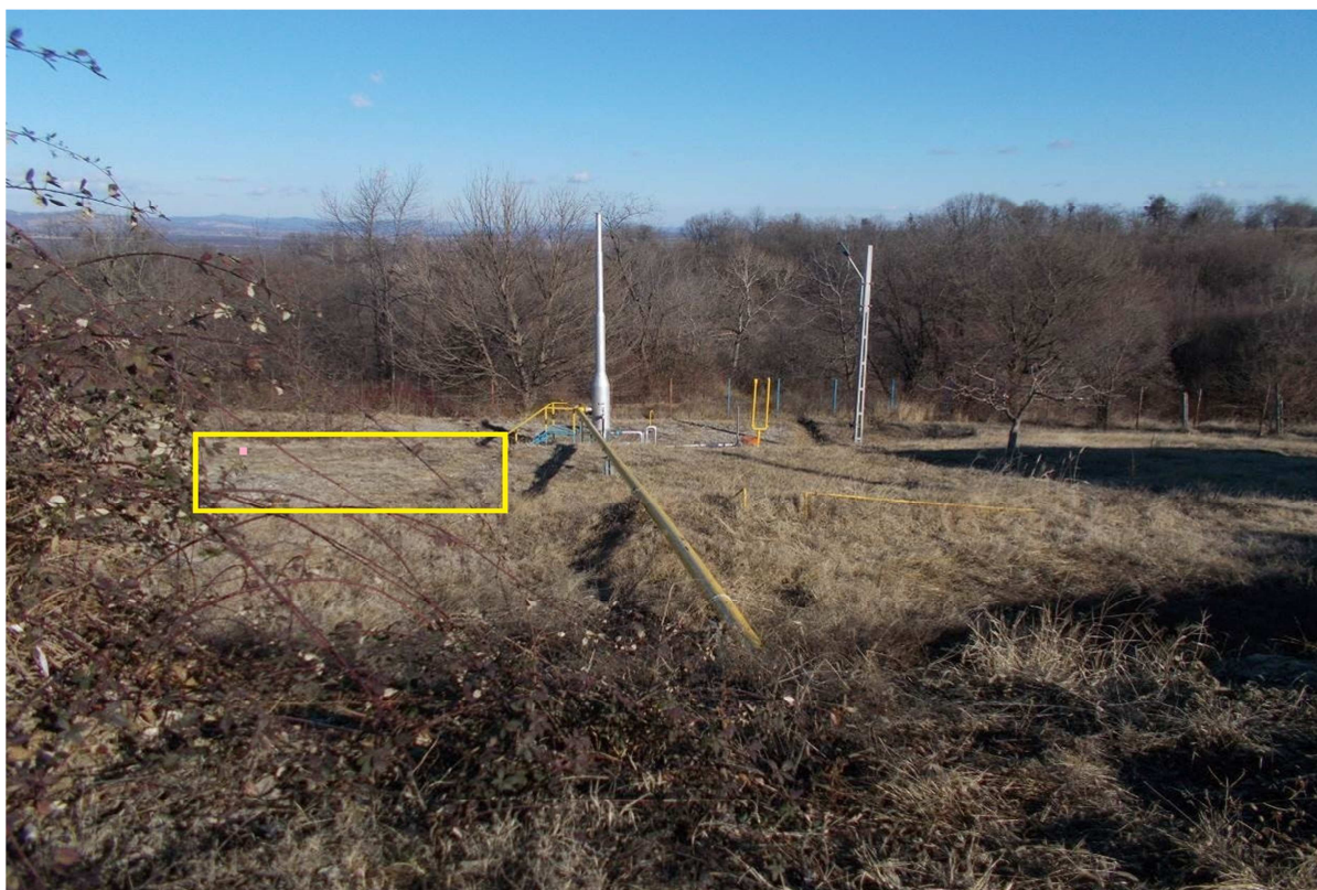
Figura 2 - Cos de gaze existent si locatia noului Vas de Picaturi
