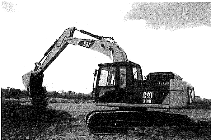
Excavator pe senile
