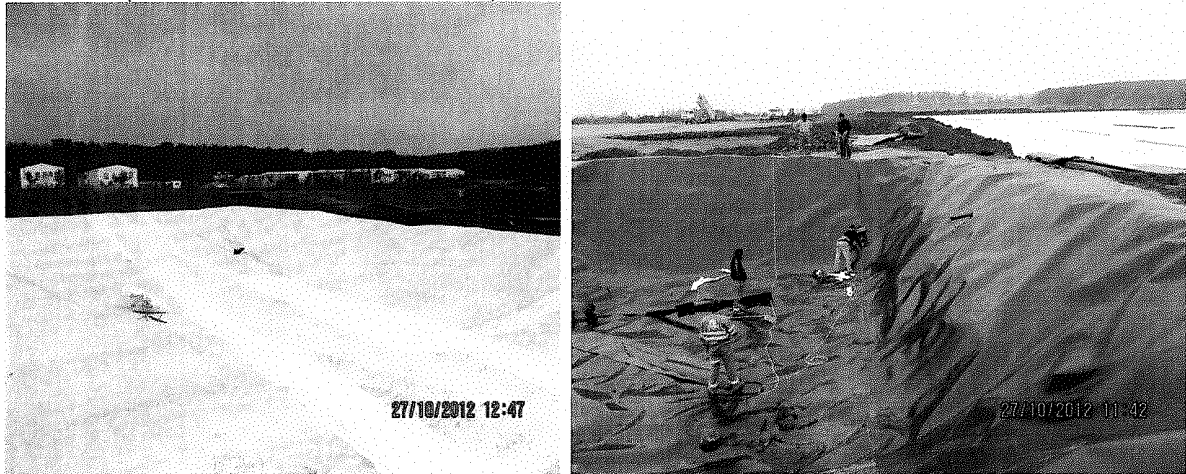
Figura nr. 3 Platforma impermeabilizata si baza colectoare
