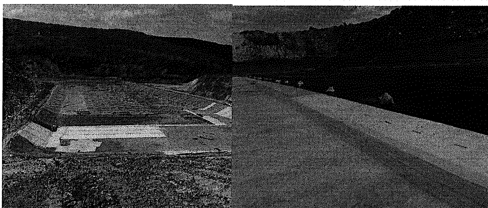
Fig. 3. Celula 6 de depozitare - impermeabilizare
