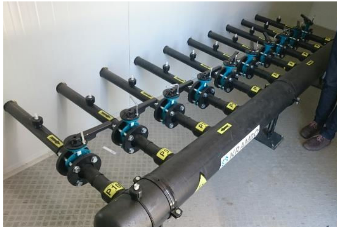
Figura 9 Imagine din proiecte similare a stației de colectare a gazului
