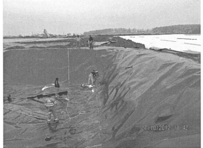
Figura nr. 3 Platforma impermeabilizată și baza colectoare
