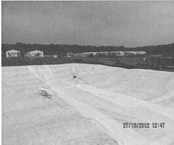
Figura nr. 3 Platforma impermeabilizată și baza colectoare
