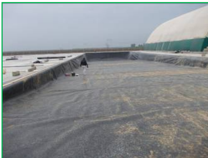
Impermeabilizare cu geomembrana PEHD la ansamblul rampa –cuvă
