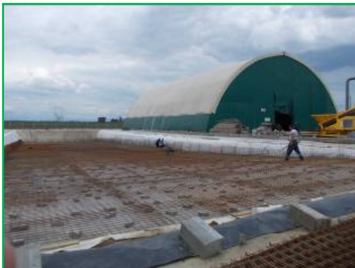
Geotextil protecție și armatura metalică la ansamblu rampa - cuva stocare/tratare deseuri
