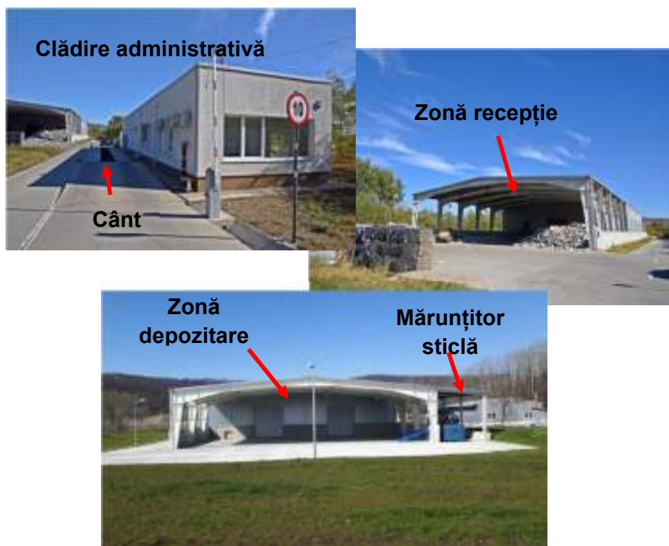
Figura 4.9. Imagini de la stația de sortare Boldești - Scăieni
