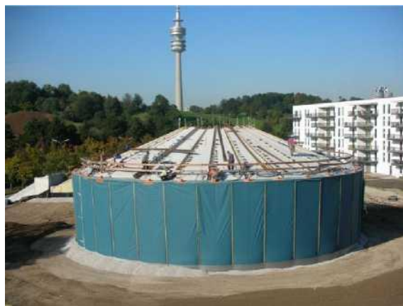
Figura 6.21 - Rezervor de stocare sezonieră a căldurii cu volumul de 5700 m 3 de apă construit din elemente prefabricate de beton în Munich (Germania) (cf. cu Pauschinger et. al., 2018)
