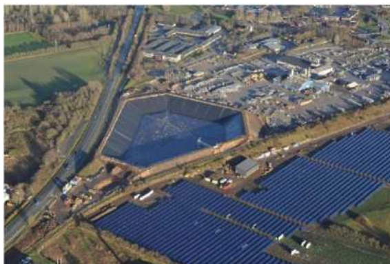
Figura 6.23 - Sistemul de încălzire centralizată cuplat cu energie solară și stocare sezonieră de căldură din Vojens (Danemarca) (cf. cu http://solarheateurope.eu )
