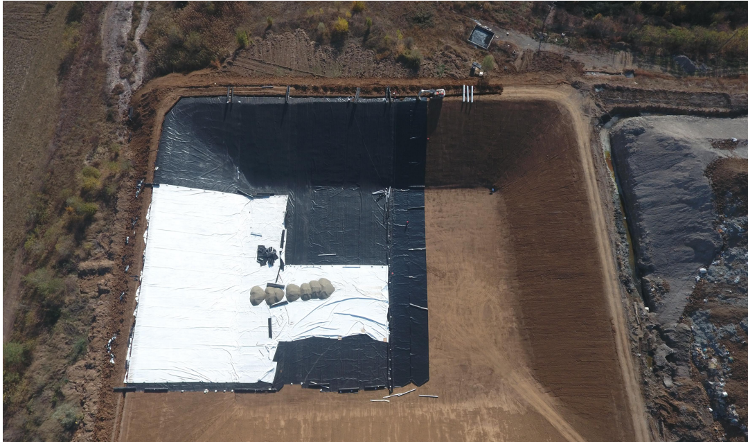
Fig. 2: Celula 3 de depozitare deseuri nepericuloase
