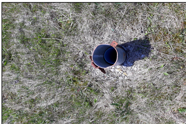
Fig. 12: Foraj monitorizare apă subterană
