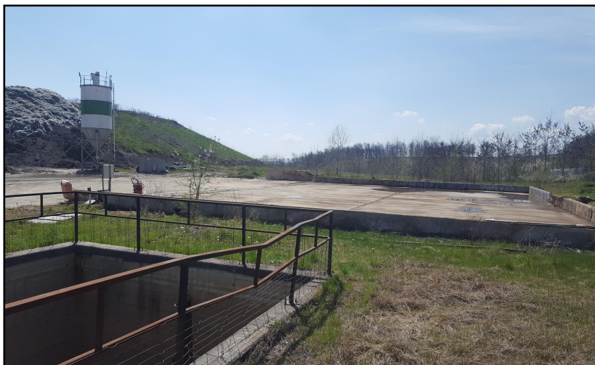
Fig. 6: Platforma betonată și bazin 100 mc
