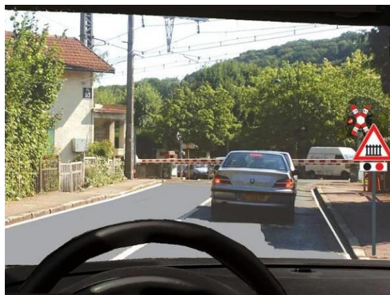
Figura 37: Exemplu de trecere la nivel cu calea ferată amenajată corespunzător (Sursă: Manual de siguranță rutieră pentru Rep. Moldova.
