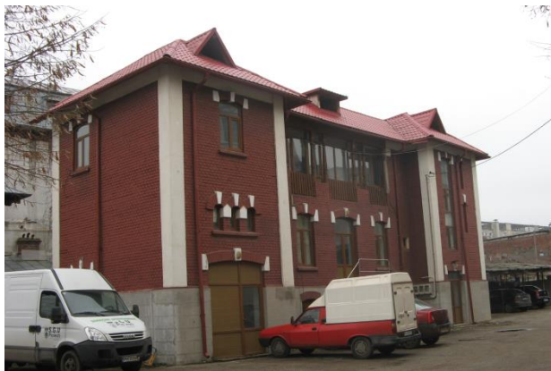
Figura 50: Clădirea în care se va amenaja Centrul de control – Str. Văleni nr. 32 (fotografii din arhiva proprie)
