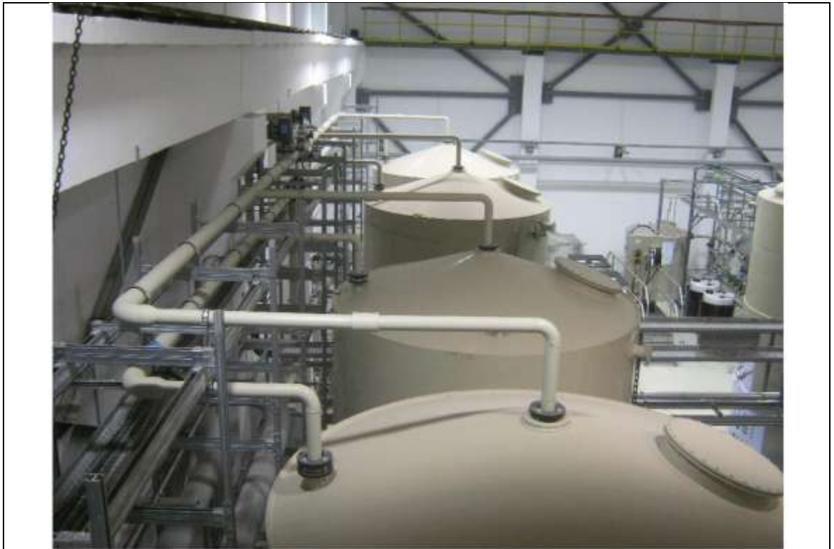
Rezervoare de stocare apă demineralizată: 4 x 30mc
