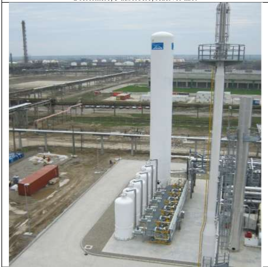
Facla; 5 adsorbere; rezervorul de gaze reziduale;
